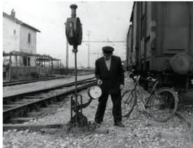
Fig. 6 - Deviatore su scambio a mano. Fig. 6 - The Switchmen on manual switches.
