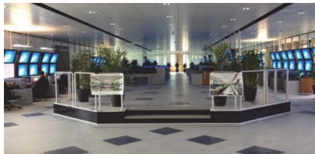
Fig. 2 - La nuova sala operativa delle Linee Metro 1, 2 e 3. Fig. 2 - The new Control Room of Metro lines 1, 2 and 3.
