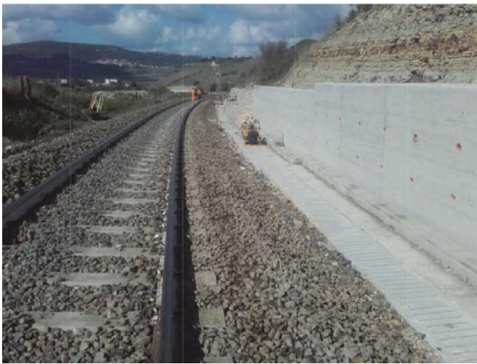
Fig. 9 - Lavori di sbancamento, posa micropali e realizzazione muro di sostegno, tratta Ploaghe-Scala di Giocca. Fig. 9 - Excavation works, installation of micropiles and retaining wall construction, on the Ploaghe-Scala di Giocca route.
