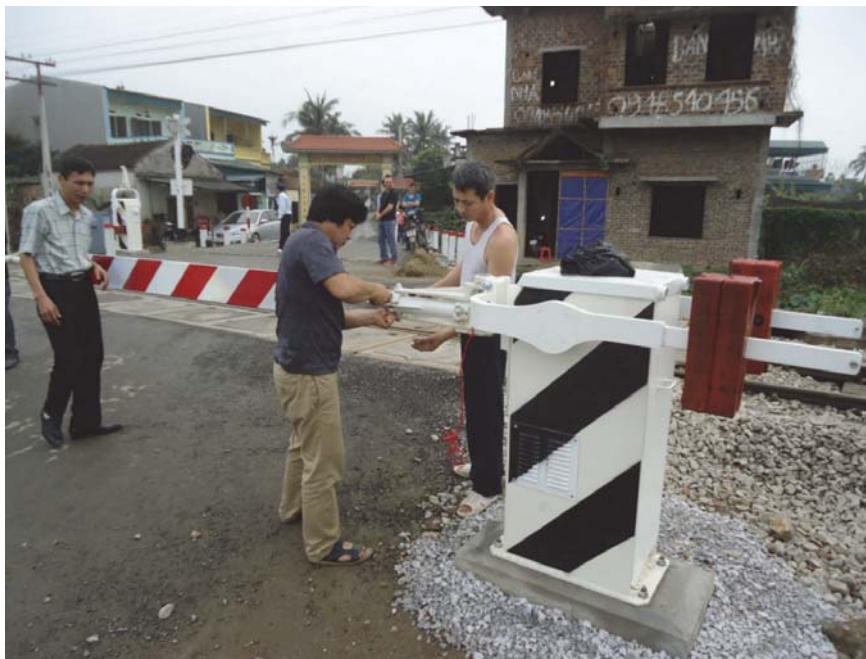
Fig. 3 - L'installazione di una cassa di manovra per pl in Vietnam. Fig. 3 - Set-up of level crossing machines in Vietnam.
