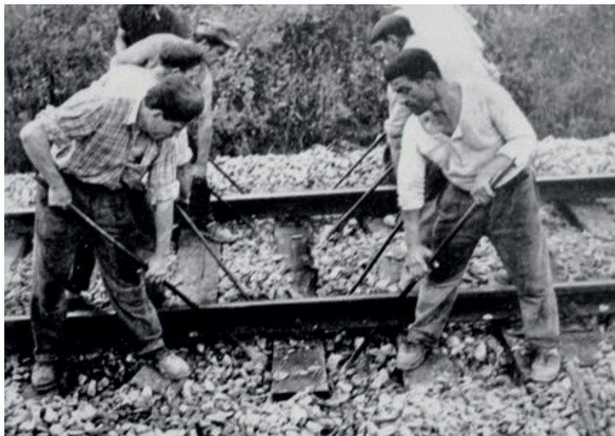
Figura 1- Rincalzatura manuale. Figure 1- Manual packing.
