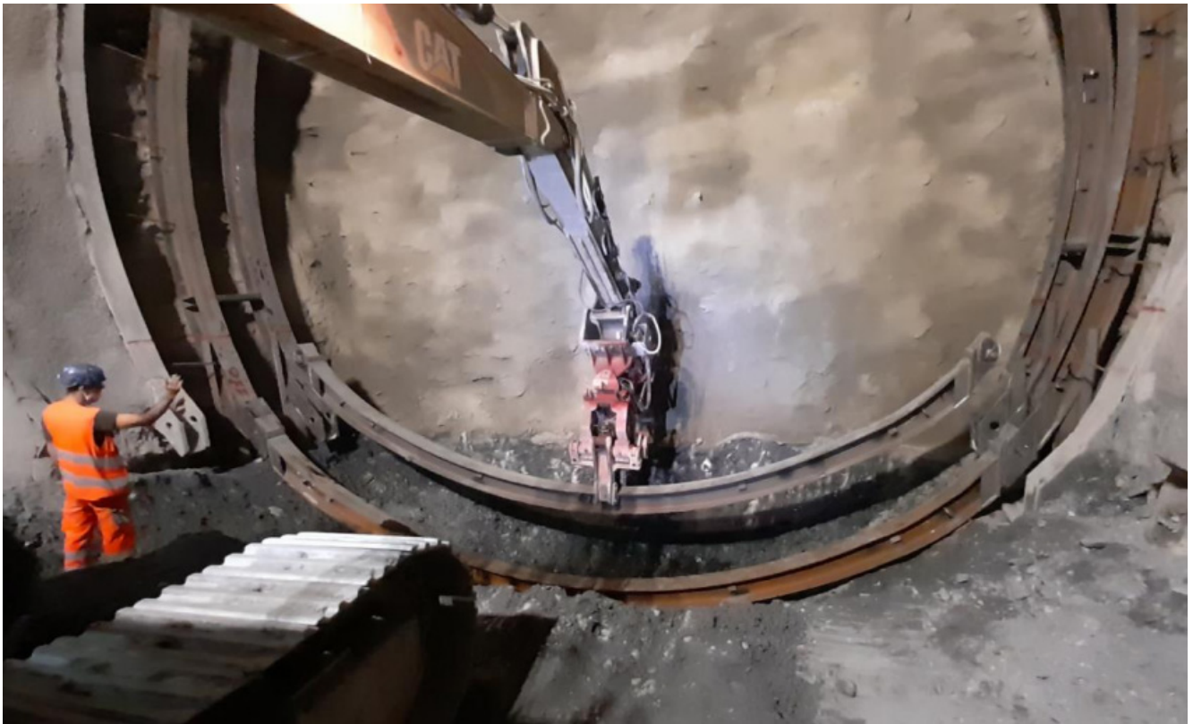
Figura 8 - Posa di puntone automatico nella centina per il rinforzo della sezione di scavo.
