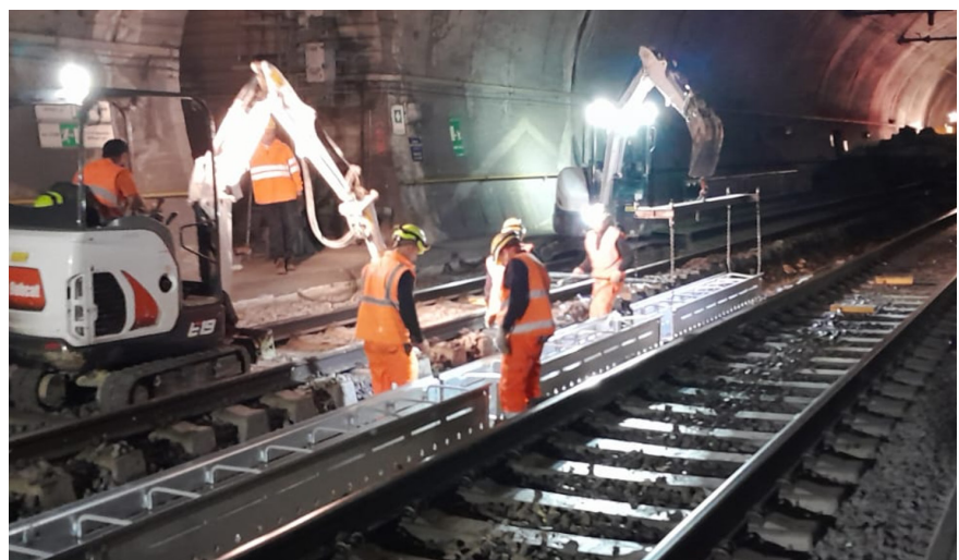
Figura 2 – Lavori in galleria in particolare mediante “water Drain System” sulla linea Pescara-Foggia.
