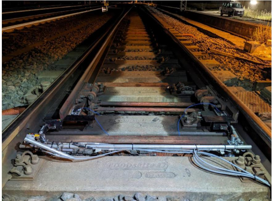
Figura 3 – Deviatoio strumentato e attrezzato con sistema di manovra P80.
