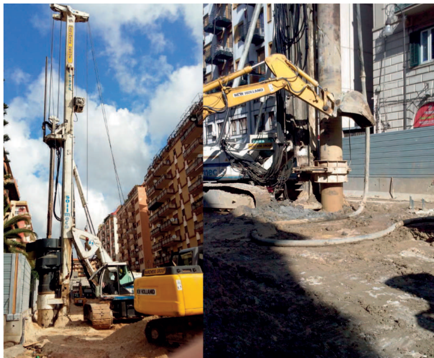
Figura 7 – L'impiego dei pali per formare i diaframmi.
