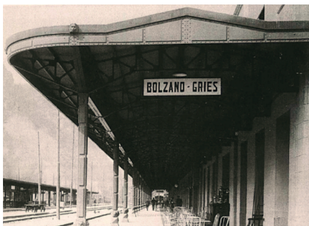
Figura 6 – Pannello per pensilina in lamiera smaltata con il “nome stazione” con caratteri stilizzati (anni '20).
