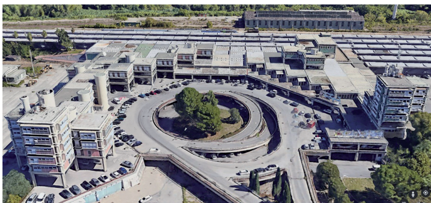
Figura 1 – Stazione ferroviaria di RFI della città di Cosenza – Immagine aerea.
