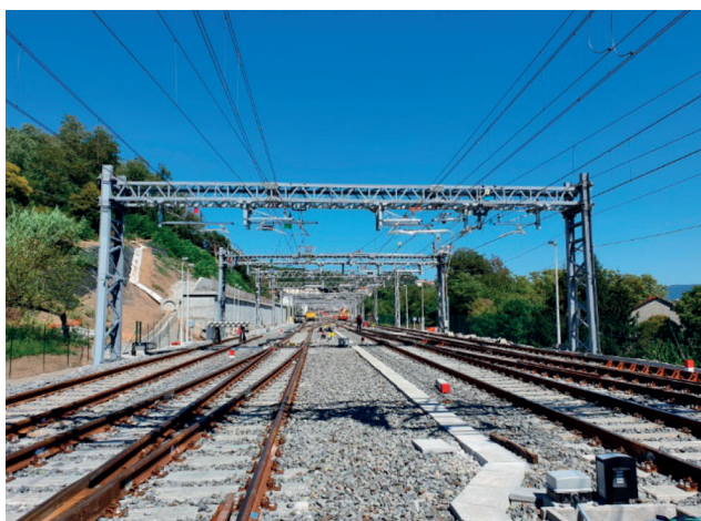
Figura 4 – Esempi di linee di contatto aeree: a sinistra una linea aerea di contatto flessibile (FOCL), a destra una linea aerea di contatto rigida (ROCL). Figure 4 – Examples of overhead contact lines: a flexible overhead contact line (FOCL) on the left, a rigid overhead contact line (ROCL) on the right.
