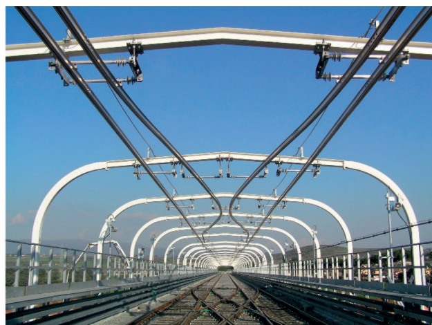
Figura 4 – Esempi di linee di contatto aeree: a sinistra una linea aerea di contatto flessibile (FOCL), a destra una linea aerea di contatto rigida (ROCL). Figure 4 – Examples of overhead contact lines: a flexible overhead contact line (FOCL) on the left, a rigid overhead contact line (ROCL) on the right.
