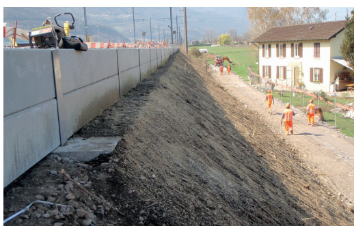
Fig. 18 - km 155,850, lato bin. 400 LEM630 definitiva - Ritenuta ghiaia definitiva con lastre prefabbricate in calcestruzzo disposte su due livelli come conseguenza della sopraelevazione del binario. Fig. 18 - km 155,850, track 400 side, permanent LEM630 - Permanent ballast retainment with prefabricated concrete slabs placed on two levels consequential to railway track lifting.
