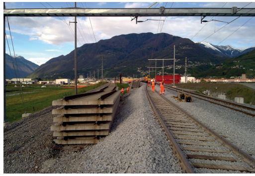
Fig. 29 - Esecuzione Fase 1c A2 – Vista del binario 400 LEM630 provvisoria in quota definitiva, spazzolato e completato a regola d'arte. Fig. 29 - Execution step 1c A2 – View of track 400, temporary LEM630, in the definitive elevation, perfectly brushed and completed.
