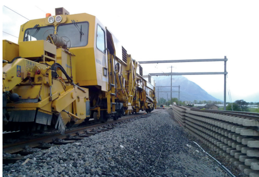
Fig. 28 - Esecuzione Fase 1c A2 – Prima rincalzatura che consentirà l'innalzamento del binario 400 LEM630 provvisoria alla quota di progetto. Fig. 28 - Execution step 1c A2 – First topping up permitting the elevation of track 400 temporary LEM630 according to the project quota.
