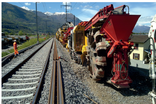
Fig. 26 - Esecuzione Fase 1c A2 – Asportazione della massicciata del binario 400 LE630 per realizzare l'innalzamento del rilevato. Fig. 26 - Execution step 1c A2 - Removal of track 400 LE630 railway ballast in order to carry out the embankment elevation.
