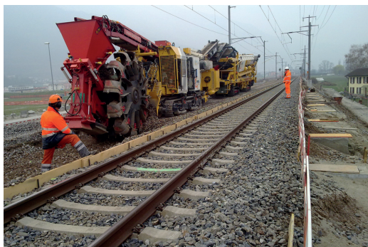
Fig. 20 - Esecuzione Fase 1b A2 - Asportazione della vecchia massiciata del binario 300. Fig. 20 - Execution step 1b A2 - Removal of old ballast on track 300.
