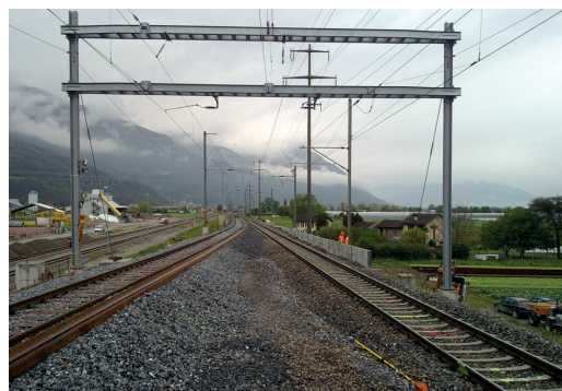
Fig. 23 - Esecuzione Fase 1b A2 - A sinistra, il nuovo binario 300 LEM630 provvisoria. A destra, il binario 400 LE630. Fig. 23 - Execution step 1b A2 - On the left, the new track 300 temporary LEM630. On the right, track 400 LE630.
