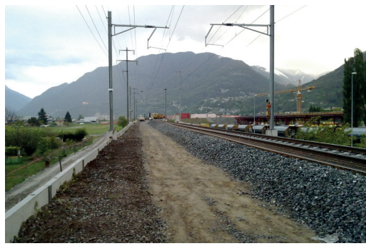
Fig. 27 - Esecuzione Fase 1c A2 – La piattaforma ferroviaria del binario 400 LE630 è stata scoperta e addensata con compattatore. Fig. 27 - Execution step 1c A2 - The railway substructure of track 400 LE630 has been uncovered and compacted.
