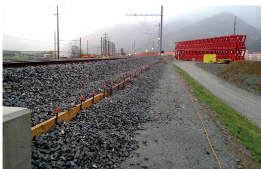
Fig. 22 - Esecuzione Fase 1b A2 - Messa in esercizio del binario 300 LEM630 provvisoria. La circolazione dei treni avviene con restrizione di velocità a 50 km/h. Fig. 22 - Execution step 1b A2 - Start-up of track 300 temporary LEM630. Train traffic is subject to speed limit 50km/h.
