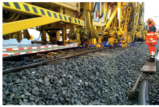
Fig. 21 - Esecuzione Fase 1b A2 - Rincalzatura del binario 300 LEM630 provvisoria. Fig. 21 - Execution step 1b A2 - Topping up of track 300 temporary LEM630.
