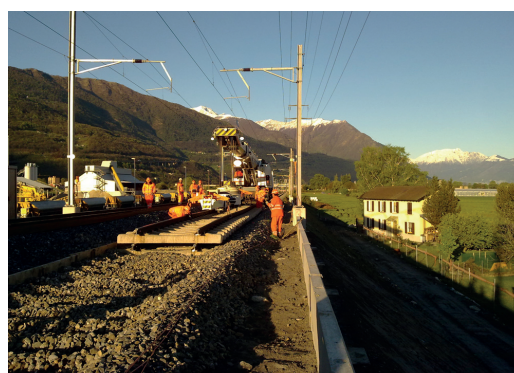
Fig. 25 - Esecuzione Fase 1c A2 - Mediante l'utilizzo di una gru ferroviaria inizia l'asportazione del binario 400 LE630. Fig. 25 - Execution step 1c A2 - Through use of railway crane, track 400 LE630 is removed.
