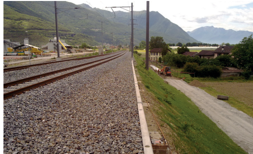
Fig. 31 - Rilevato LEM (km 155,800, lato binario 400 LEM630 definitiva) – Vista della sezione trasversale completa nella zona dove il tracciato modificato si innesta su quello storico. Fig. 31 - LEM Embankment (km 155,800, side of track 400, permanent LEM630) - View of the completed transversal section in area where the modified track layout links with the existing one.
