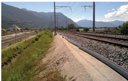
Fig. 32 - Rilevato LEM (km 155,700, lato binario 300 LEM630 provvisoria) - E' stata rimossa la ritenuta ghiaia con tavole di legno ed è stata costruita a regola d'arte la banchina.
