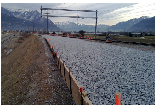
Fig. 16 - km 155,600, lato bin. 300 LEM630 provvisoria - Primo strato di massiciata che viene stesa in spessori di circa 0,3 m ad ogni posa. Ogni strato viene vibro-compattato. Fig. 16 - km 155,600, track 300 side, temporary LEM630 - First ballast layer spread (0,3 m thickness each layer). Each layer is vibro-compacted.
