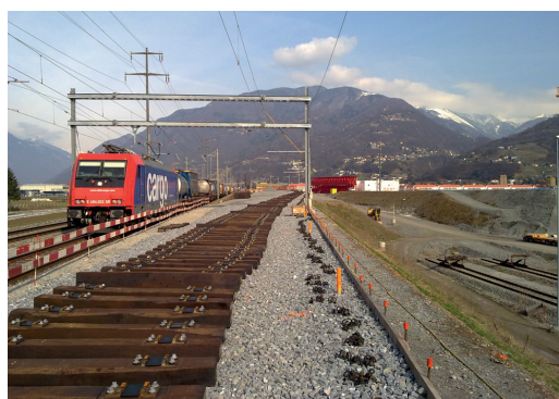
Fig. 19 - km 155,750, LEM630 definitiva - Costruzione della sovrastruttura ferroviaria del binario 300. Fig. 19 - km 155,750, permanent LEM630 - Construction of the railway superstructure on track 300.
