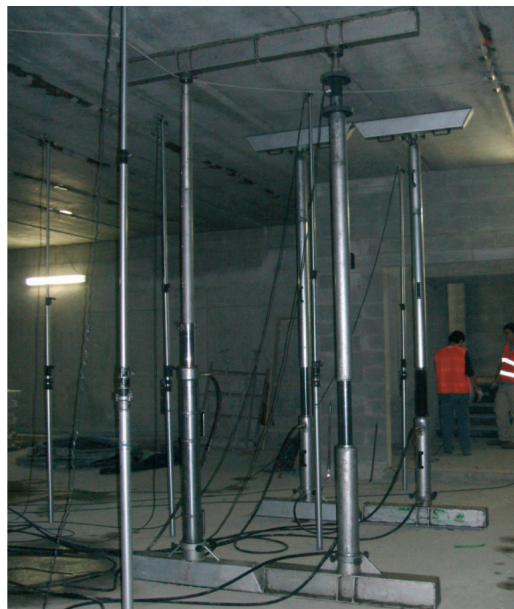
Fig. A4 - Pistoni idraulici di carico del solettone intermedio contrastati dal solettone superiore. Hydraulic load pistons of the intermediate slab contrasted by the upper slab.
