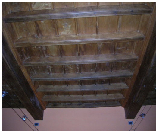
Foto 1 - Solaio in legno misto. Mixed wood floor.
