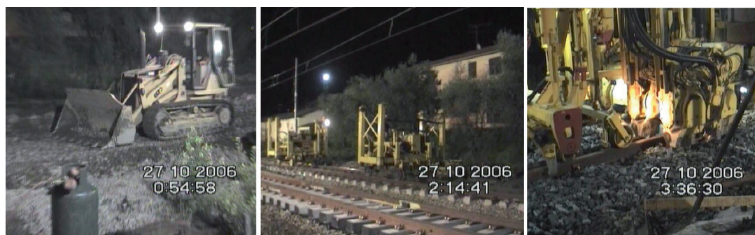
Fig. 2 – Fasi di lavorazione nell'attività di "demolizione e varo scambio".
