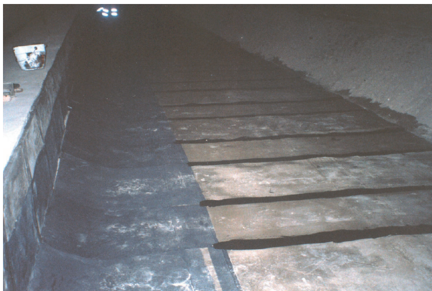
Figura 14 – Vista della vasca di contenimento della sede ferroviaria, dalla quale è stata rimossa la massicciata ed installato un materassino resiliente [20]. Figure 14 – View of the containment tank of the railway site, from which the ballast has been removed and a resilient mat installed [20].
