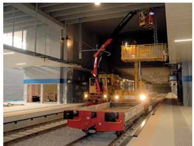
Fig. 8 - Nella stazione Malpensa Terminal 2 si lavora alla linea aerea che risulta pressoché completata. Sullo sfondo il termine della linea che, una volta completati e resi esecutivi i progetti, proseguirà come evidenziato nella cartina di fig. 7.
