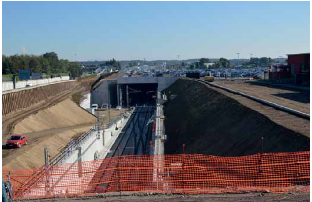
Fig. 6 - L'ultimo tratto di linea in superficie prima di giungere alla stazione sotterranea Malpensa Terminal 2 che si intravede sullo sfondo insieme agli edifici aeroportuali del T2.
