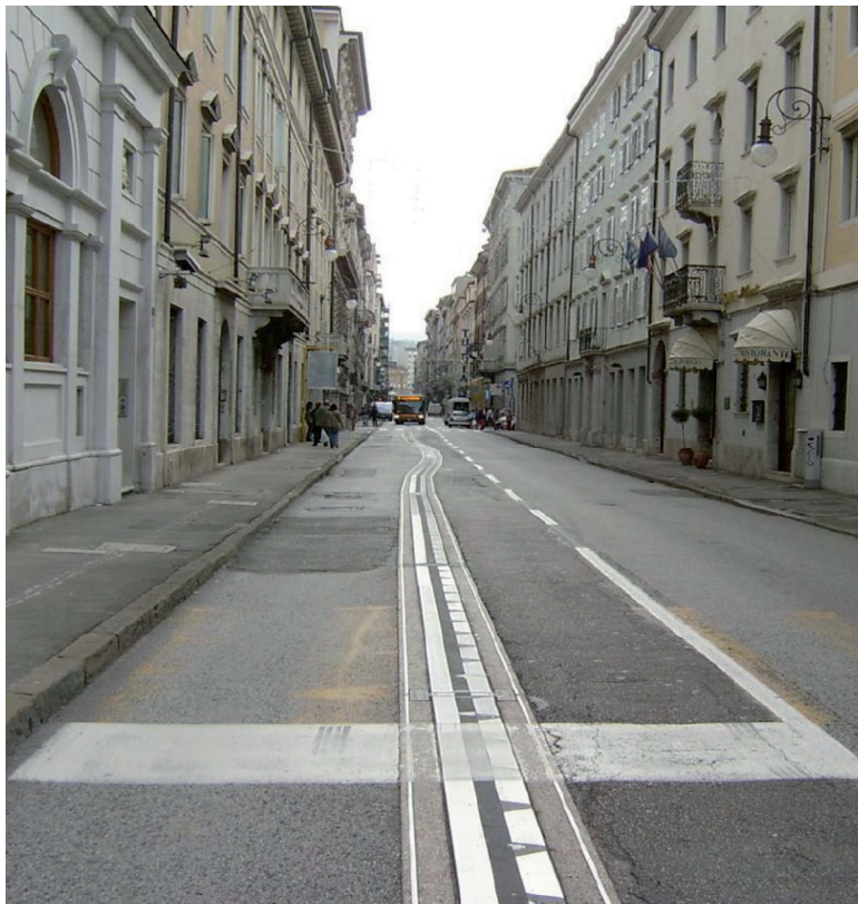
Fig. 1 - Il sistema Tramwave: la pista di contatto per l'alimentazione della trazione. Fig. 1 - The system Tramwave: the track of contact for the supply of traction.
