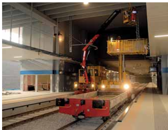
Fig. 8 - Nella stazione Malpensa Terminal 2 si lavora alla linea aerea che risulta pressoché completata. Sullo sfondo il termine della linea che, una volta completati e resi esecutivi i progetti, proseguirà come evidenziato nella cartina di fig. 7.
