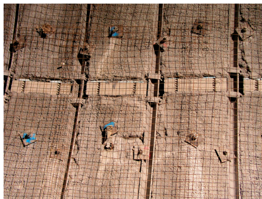
Fig. 9 – Elementi in calcestruzzo altamente comprimibili inseriti nel rivestimento in calcestruzzo spruzzato. Highly compressible concrete elements inserted in the shotcrete lining.
