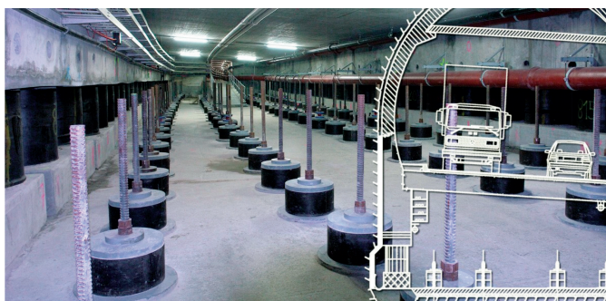
Fig. 19 - Galleria Stradale di Chienberg dopo il completamento: "Sostegno Cedevole Modulare". Chienberg Road Tunnel after completion: "Modular Yielding Support".
