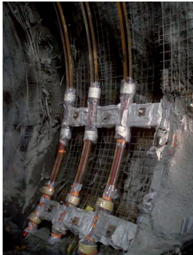
Fig. 7 Supporti deformabili con elementi HiDCon incorporati nel rivestimento di calcestruzzo spruzzato e in centine deformabili. Dettagli delle installazioni all'interno della discenderia di Saint Martin La Porte. Yielding support with HiDCon elements incorporated in the shotcrete lining and between steel sets with yielding couplings. Installation details as adopted in the Saint Martin La Porte access tunnel.
