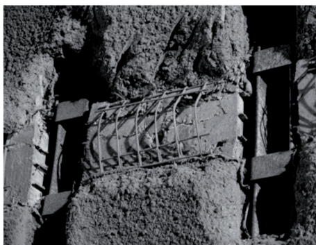
Fig. 7 Supporti deformabili con elementi HiDCon incorporati nel rivestimento di calcestruzzo spruzzato e in centine deformabili. Dettagli delle installazioni all'interno della discenderia di Saint Martin La Porte. Yielding support with HiDCon elements incorporated in the shotcrete lining and between steel sets with yielding couplings. Installation details as adopted in the Saint Martin La Porte access tunnel.
