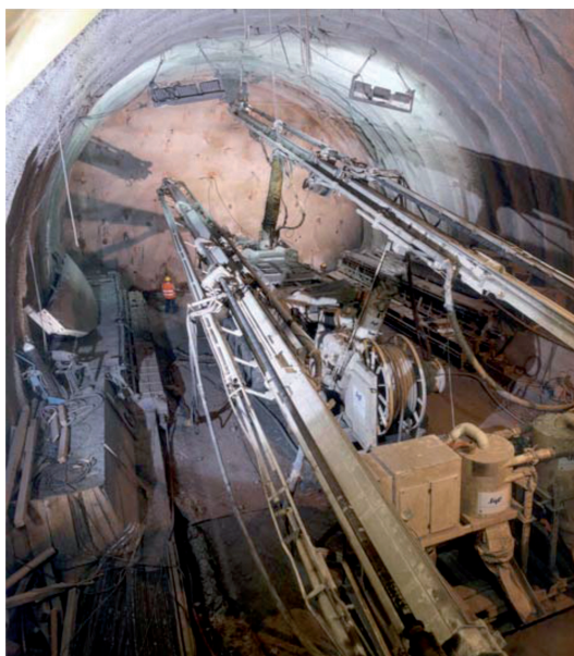
Fig. 3 – Metodi di avanzamento a piena sezione: operazioni di consolidamento del fronte e di chiusura dell'arco rovescio. Full face excavation/construction method: face reinforcement and ring closure operations.
