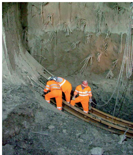
Fig. 3 – Metodi di avanzamento a piena sezione: operazioni di consolidamento del fronte e di chiusura dell'arco rovescio. Full face excavation/construction method: face reinforcement and ring closure operations.
