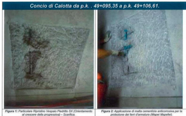
Figura 3 – Esempio di Non Conformità inserita nel set informativo di un concio di galleria nella progressiva corrispondente all'interno del modello informativo. Figure 3 – Example of Non-Conformity included in the information set of a gallery section in the corresponding point within the information model.
