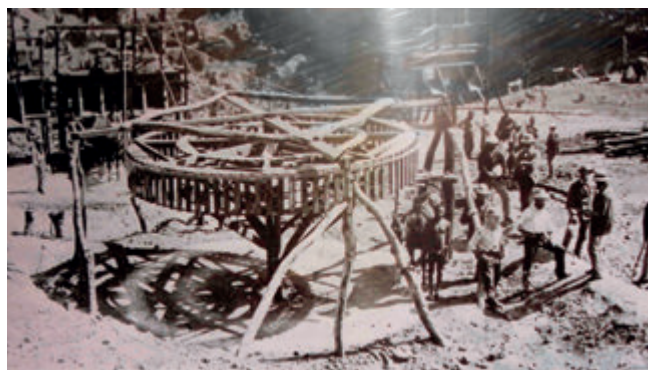
Fig. 19 - 1886. Il sistema di trasporto, realizzato con il legname reperibile sul posto, per il lavaggio del materiale diamantifero macinato da sottoporre a successiva vagliatura.
