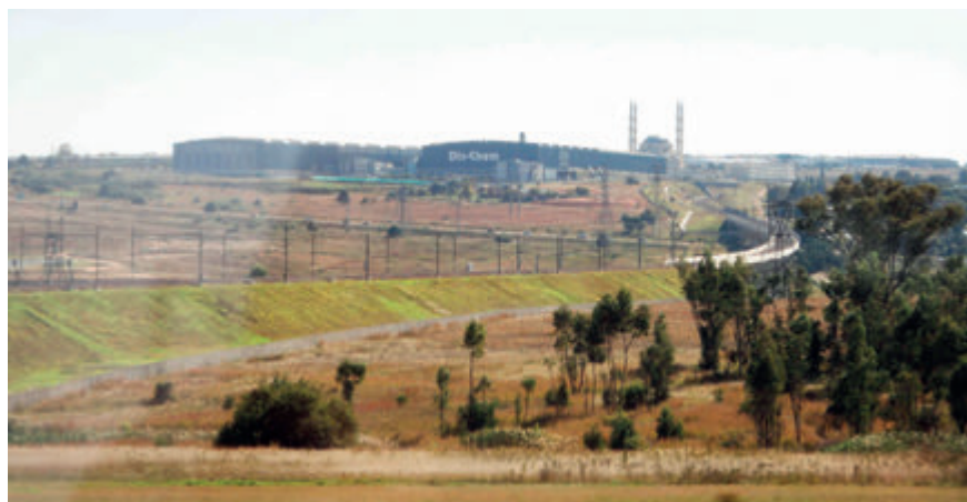
Fig. 12 - Vista di una tratta della linea in rilevato e viadotto. In lontananza i sobborghi industriali di Johannesburg e i pinnacoli di una moschea.
