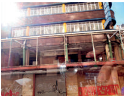
Fig. 17 - Down Town di Johannesburg. Interi edifici sono sigillati per evitarne l'occupazione o completamente vandalizzati.
