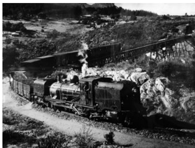
Fig. 30 - La capacità d'iscrizione in curva della locomotiva "Garrant" classe NGG 16 del 1939 su binario a scartamento 610 mm.
