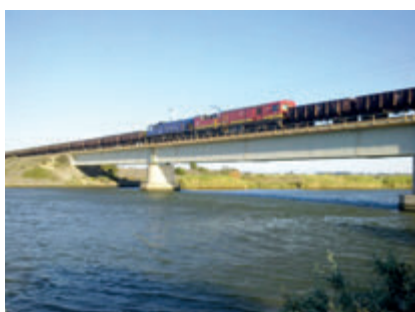
Fig. 33 - Vista delle unità di trazione del treno situate in posizione intermedia.
