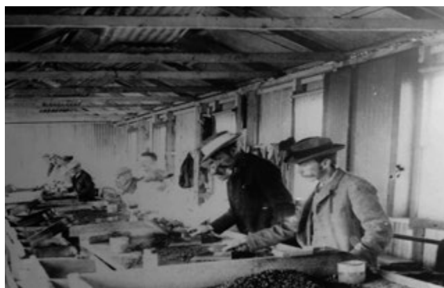
Fig. 20 - 1886. Vagliatura a mano del minerale diamantifero.
