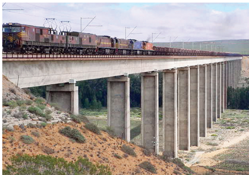
Fig. 34 - L'attraversamento del "Olifants River Bridge" lungo 1.035 m.
