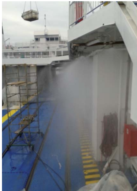
Fig. 24 – Prova dell'impianto antincendio durante la costruzione. Fig. 24 – Test of the sprinkler system during the ships' construction.
