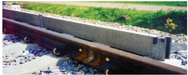
Fig. 11 – Esempio di barriere acustiche basse. Fig. 11 – Example of low acoustic barriers.
