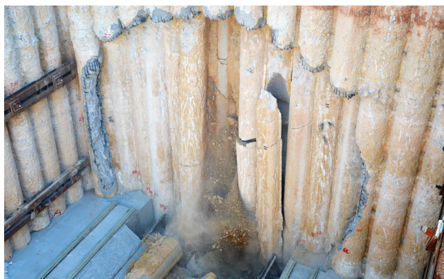
Fig. 3 e 4 - Sequenza dell'abbattimento dell'ultimo diaframma.
