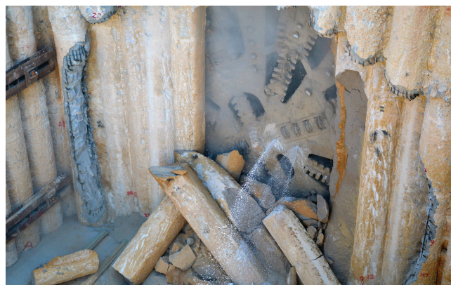
Fig. 3 e 4 - Sequenza dell'abbattimento dell'ultimo diaframma.
