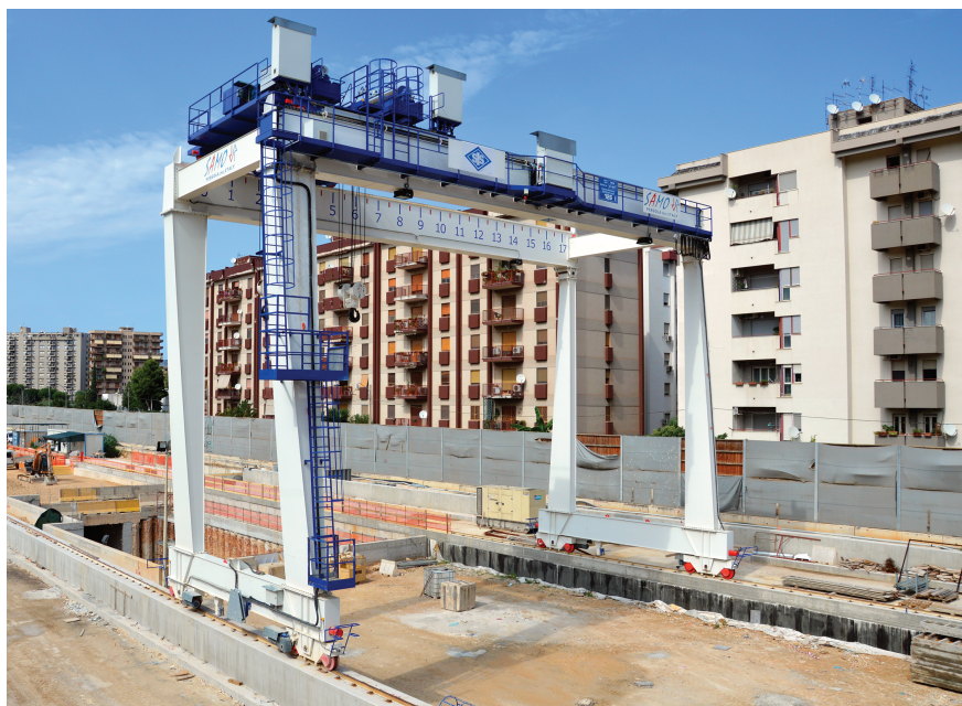
Fig. 1 - Il pozzo di uscita della TBM e la gru a portale.
