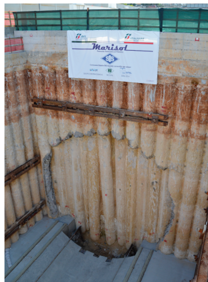
Fig. 2 - La paratia predisposta per l'uscita della "talpa".
