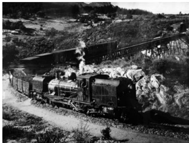
Fig. 30 - La capacità d'iscrizione in curva della locomotiva "Garrant" classe NGG 16 del 1939 su binario a scartamento 610 mm.
