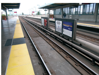
Fig. 28 - Banchine 213 m; scartamento 1676 mm.
