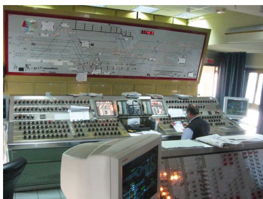
Fig. 3a - L'ex ufficio movimento ACELI di Pisa come si presentava durante le fasi propedeutiche all'attivazione dell'ACC; in primo piano il banco del dirigente movimento con il terminale Train Describer del SCC, in secondo piano il banco del deviatore e il quadro luminoso dell'apparato. Interior of the ACELI cabin of Pisa as it appeared before the ACC activation; it is shown the traffic controller desk with the SCC Train Describer terminal and the visual control panel and the control desk of the apparatus.
