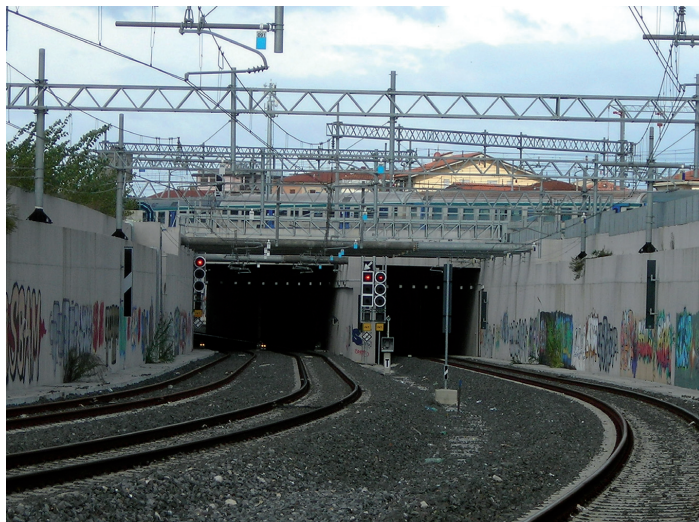
Fig. 5b - Foto dell'opera civile "scavalco": la linea ferroviaria superiore è la Firenze-Pisa, in sottoattraversamento: la linea Pisa-Roma (Tirrenica) e Pisa-Vada. Picture of the civil work called "scavalco" that avoid the interference between the line Florence-Pisa (upper line) and the lines Pisa-Rome and Pisa-Vada.
