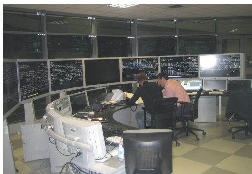
Fig. 14a - Nuovo ufficio movimento nel posto centrale ACC di Pisa durante le prove; a sinistra: il banco operatore movimento n.1, a destra: il banco operatore movimento n.2. New traffic control room in the ACC central post of Pisa during commissioning tests; on the left: the traffic operator desk n. 1, on the right: the traffic operator desk n. 2.
