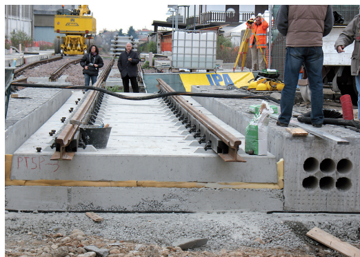
Foto 8 - La posa di un attraversamento su platee prefabbricate: Bergamo, via Bianzana.
