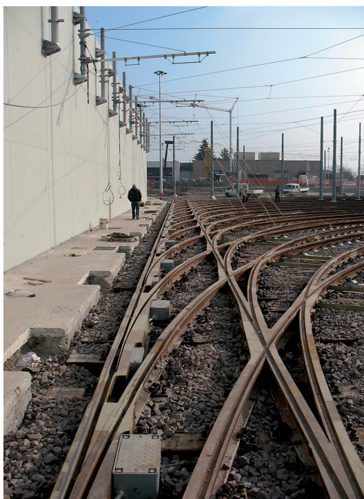
Foto 9 - Il "pettine" per l'ingresso al deposito durante la posa della linea aerea.
