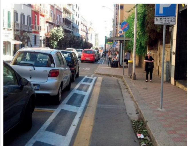
D - Pista ciclabile interrotta in fermata (non idoneo) - Molo (Fonte: http://www.ingdemurtas.it/bici/ciclabile-fermata-bus/ ) D - Cycle path interrupted at stop (not suitable) - Full-width boarder (Source: http://www.ingdemurtas.it/bici/ciclabile-fermata-bus/ )
