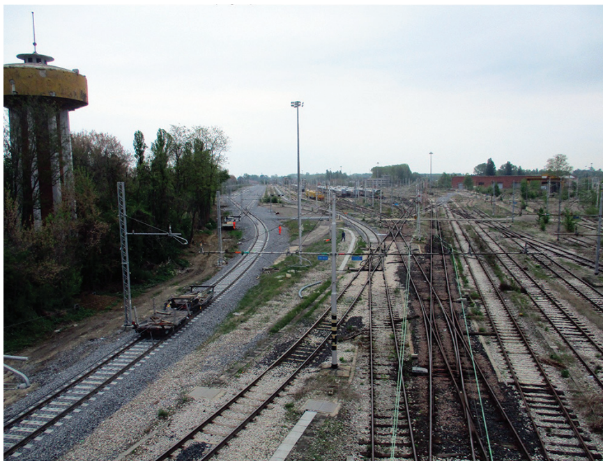
Fig. 6 – Stato di avanzamento dei lavori di costruzione. A sinistra: il nuovo binario in fase di completamento. Sullo sfondo al centro: alcuni rotabili in attesa del collaudo, fra cui i treni Pop, Rock ed alcune macchine operatrici della Plasser & Theurer.
