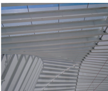
Fig. 17 - Particolari dei vetri montati tra i portali orizzontali di copertura. Fig. 17 - Details of the glass panes in between the horizontal portals coverage.
