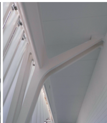
Fig. 21 - Particolare della stampella in acciaio che sorregge la trave di banchina. Fig. 21 - Detail of steel crutch that sorregge the platform beam.
