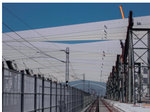
Fig. 10 - Particolare della fase di montaggio dei portali di copertura, sullo sfondo il ponte di CALATRAVA che attraversa l'autostrada A1. Fig. 10 - Detail of the assembly of the portals of coverage, in the background the CALATRAVA bridge that crosses the A1 motorway.
