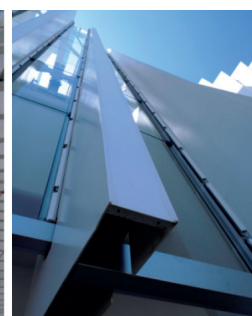
Fig. 18 - Particolari dei vetri montati tra i portali verticali di facciata. Fig. 18 - Details of the glass panes in between the vertical portals façade.
