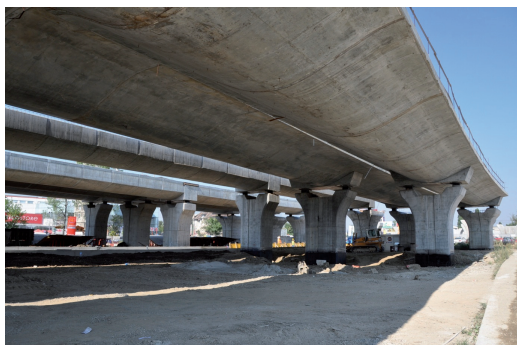
Fig. 11 - Stato di avanzamento dei lavori del viadotto di collegamento.
