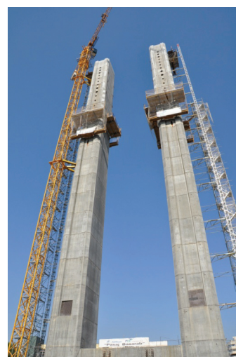
Fig. 12 - La pila centrale del ponte stralato.
