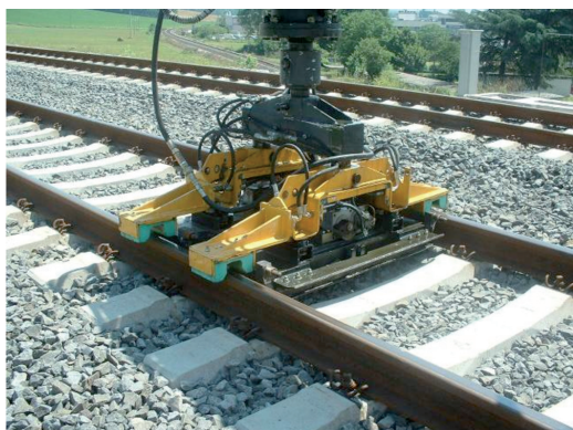
Fig. 24 - Abbassamento della quota del ballast. Lowering of the ballast height.
