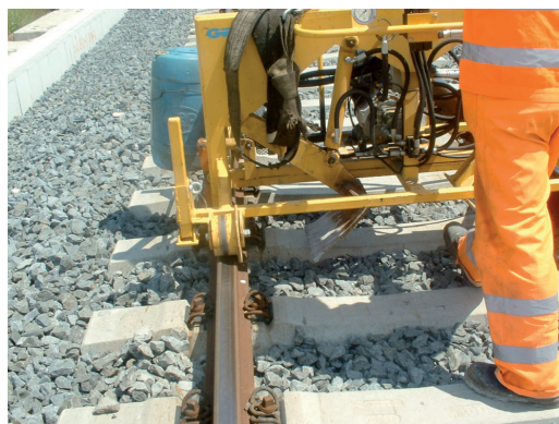
Fig. 25 - Svanatura del pietrisco nella zona sottorotaia. Removal of ballast from the areas under the rails.
