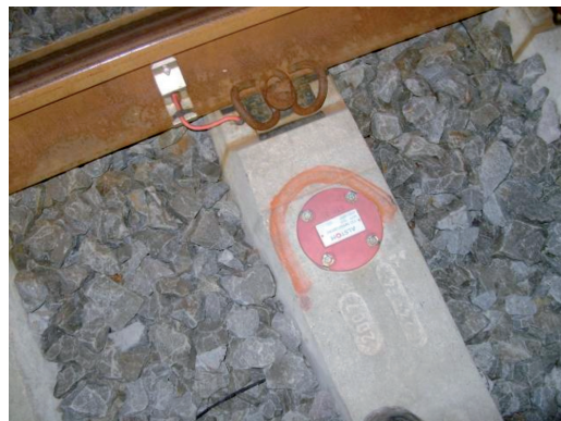
Fig. 21 - Traversa RFI 260 CdB. Sleeper RFI 260 CdB.
