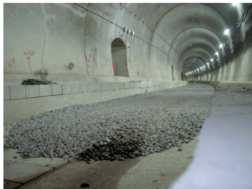
Fig. 13 - Galleria Interconnessione San Ruffillo. Primo strato di pietrisco. San Ruffillo branching line tunnel. First ballast layer.
