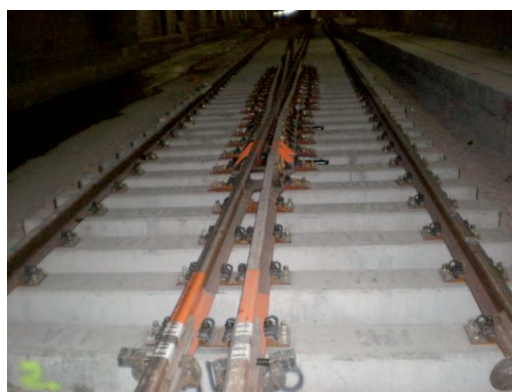
Fig. 23 - Deviatore S60U/1200/0,040 c.p.m. in fase di costruzione. Particolare zona del cuore. Movable frog point of type S60U/1200/0,040 under construction. Detail of the frog.
