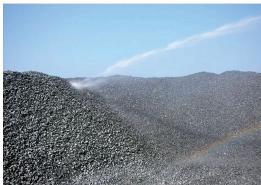
Fig. 15 - Bagnatura del ballast prima della posa del primo strato. Ballast washing before the laying of the first layer.
