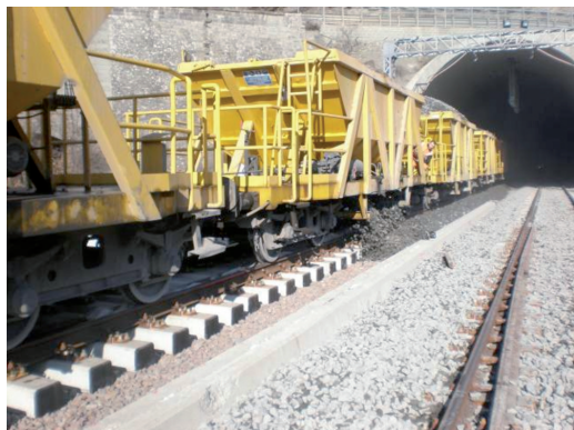
Fig. 22 - PM di San Pellegrino. Scarico del ballast dai carri tramoggia. PM di San Pellegrino. Ballast unloading from the hopper wagons.
