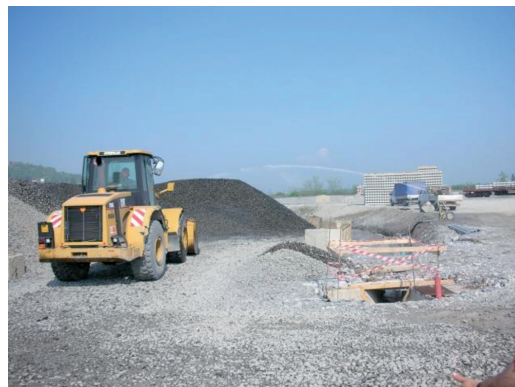
Fig. 14 - Bagnatura del ballast prima della posa del primo strato. Ballast washing before the laying of the first layer.
