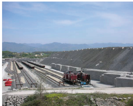
Fig. 7 - Cantiere di armamento CAR1. Area di stoccaggio ballast e traverse. Permanent way yard CAR1. Ballast and sleeper storage area.
