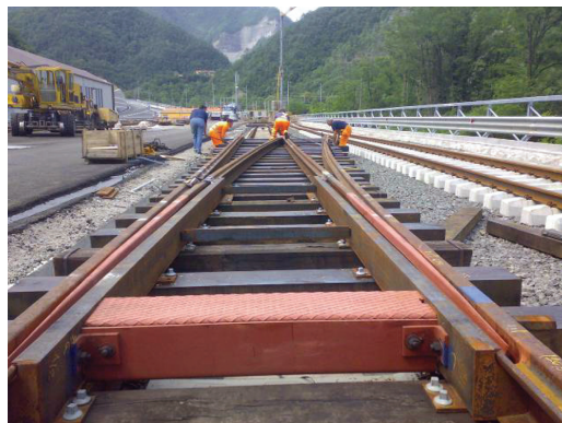
Fig. 5 - Scambio a gola 68G1/150/0,13 durante le fasi di montaggio nel Piazzale di San Pellegrino. Groove point of type 68G1/150/0,13 during the mounting phases in the San Pellegrino yard.
