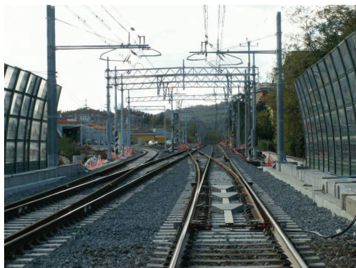
Fig. 4 - Bivio Emilia. Innesto interconnessione sulla linea storica Firenze-Bologna. Emilia Junction. Branching line section joining the historical line Florence-Bologna.
