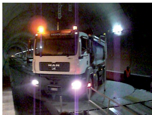
Fig. 9 - Galleria Fiorenzuola. Formazione primo strato di ballast. Piattaforma girevole. Fiorenzuola Tunnel. Formation of the first ballast layer. Movable turntable.
