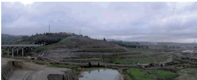
Fig. 23 - Il versante di Tracoccia dopo l'intervento di riprofilatura con rilevato di stabilizzazione. The Tracoccia slope after the re-profiling intervention with a stabilization embankment.
