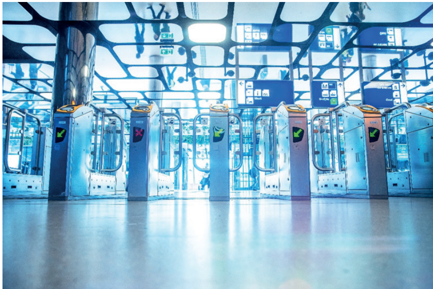
Figura 4 - Sistema di riscossione automatica delle tariffe per la Fase 2 del progetto MRT di Giacarta.
