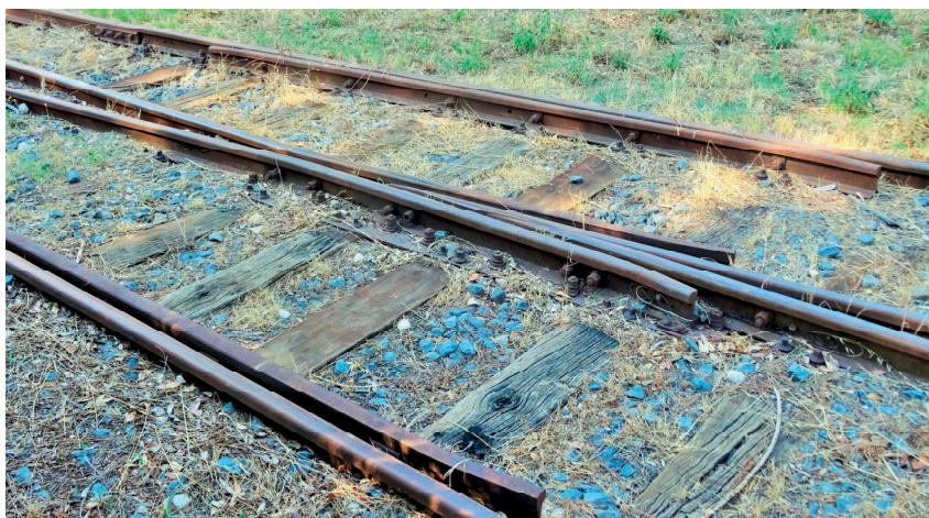
Figura 3 – Cuore di rotaie e controrotaia di uno scambio FS 46 U. Figure 3 – Rail frog and check rail of an FS 46 U turnout.
