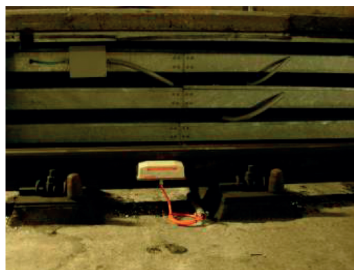
Fig. 4 - Modulo Riconoscimento Rotabili: sensori di ruota. Fig. 4 - Rolling stock Recognition Module : wheel sensors.
