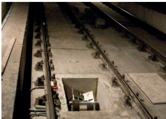
Fig. 7 - Installazione Termografo del Sistema RTST. Fig. 7 - RTST system thermograph installation.
