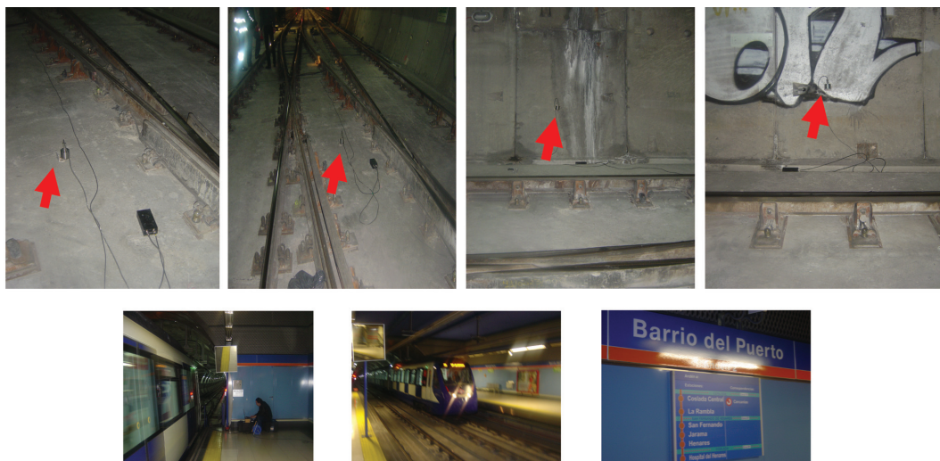
Fig. 5 - Punti di misurazione delle vibrazioni nella Metro di Madrid (Barrio del Puerto) – Vista del veicolo normalmente utilizzato nella campagna di misurazioni. Vibration measurement locations at the tunnel wall and invert of Madrid Metro (Barrio del Puerto) – View of the typical vehicle used in the measurement campaign.
