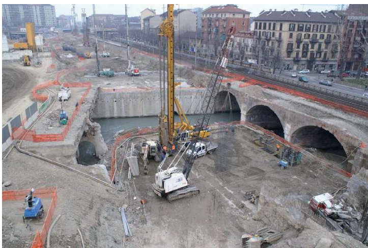
Fig. 7 - Penisola di lavoro in alveo per la realizzazione delle opere strutturali. Peninsula for working in the riverbed so as to realize the structural works.
