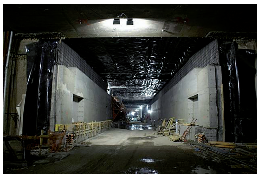
Fig. 6 - Sottoattraversamento fiume Dora – Impermeabilizzazione contro soletta. Rive Dora underpass – Waterproofing of counter-slabbing.
