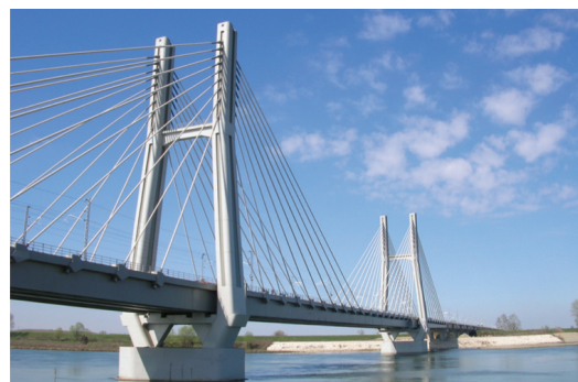
Fig. 3.18 – Veduta del ponte strallato sul Po. View of the cable-stayed bridge on the river Po.
