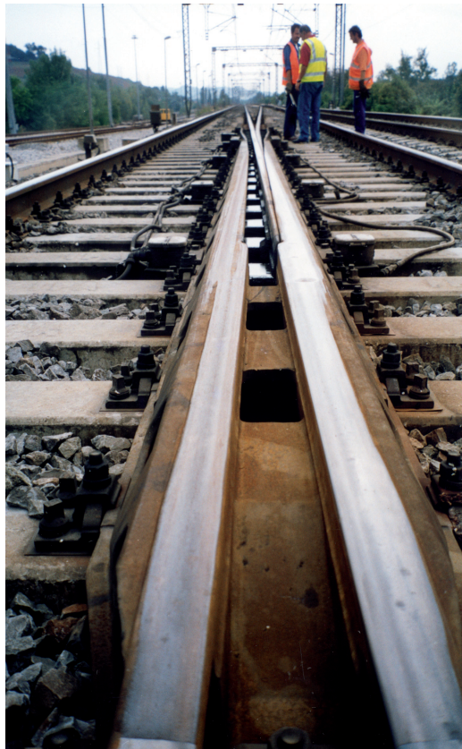
Fig. 5 – Scambio tg. 0.022 P.C. Renacci - Vista del cuore a punta mobile.
