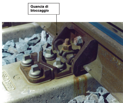
Fig. 12 - Scambio tg. 0.022 al P.M. di Alice Linea AV/AC TO- NO Cuscinetto elastico con guancia di bloccaggio.
