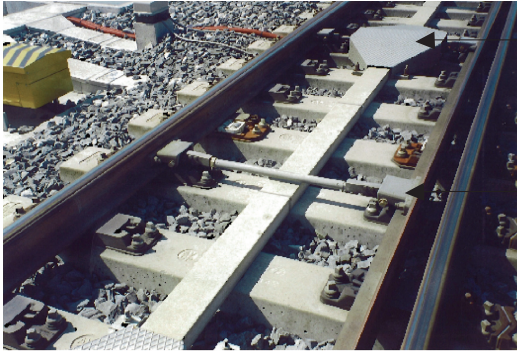
Fig. 21 – Scambio tg. 0.074 al P.M. di Alice Linea AV/AC TO-NO Particolare della manovra.
