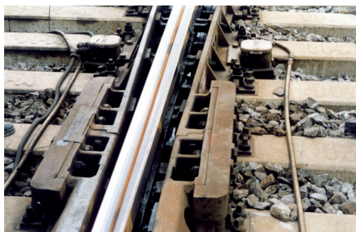
Fig. 6 – Scambio tg. 0.022 P.C. Renacci - Particolare del giunto di collegamento delle culle in Acciaio al Mn.
