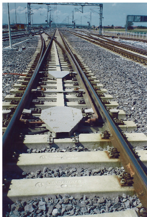
Fig. 17 – Scambio tg. 0.074 al P.M. di Alice Linea AV/AC TO– NO Vista globale dello scambio.
