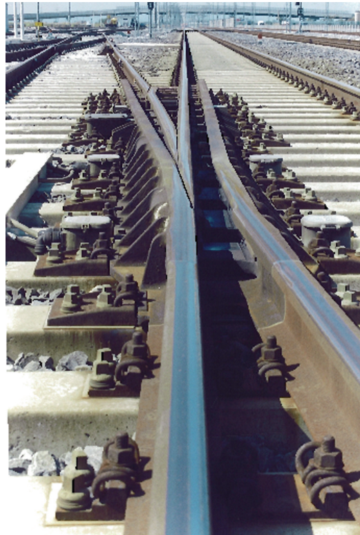
Fig. 22 – Scambio tg. 0.074 al P.M. di Alice Linea AV/AC TO-NO Cuscinetto con rulli.
