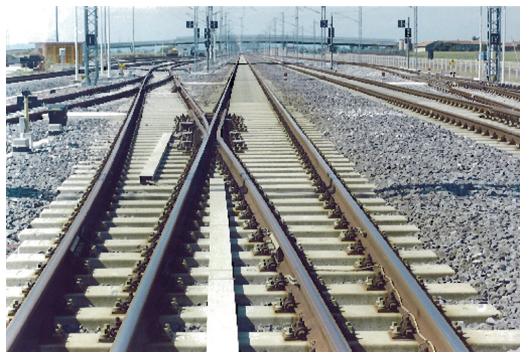
Fig. 18 – Scambio tg. 0.074 al P.M. di Alice Linea AV/AC TO– NO Zona delle intermedie.
