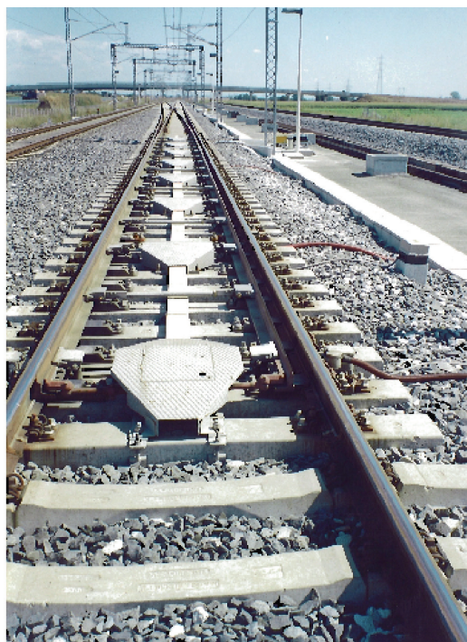
Fig. 9 - Linea AV/AC Torino - Novara - Vista dello scambio tg. 0,022 al P.M. di Alice Castello.
