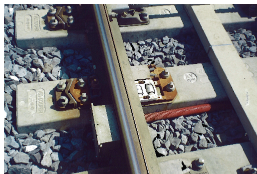
Fig. 11 - Scambio tg. 0.022 al P.M. di Alice Linea AV/AC TO- NO Cuscinetto elastico con rulli.
