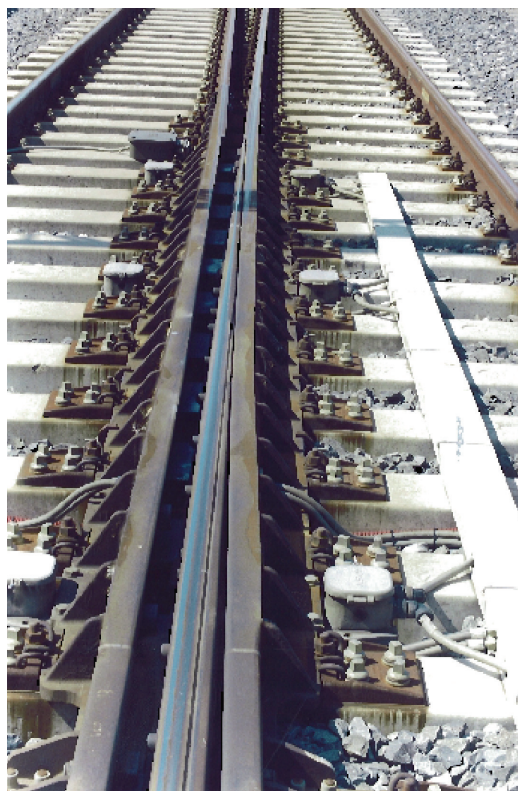
Fig. 16 – Scambio tg. 0.022 al P.M. di Alice Linea AV/AC TO– NO Particolare della culla del cuore.
