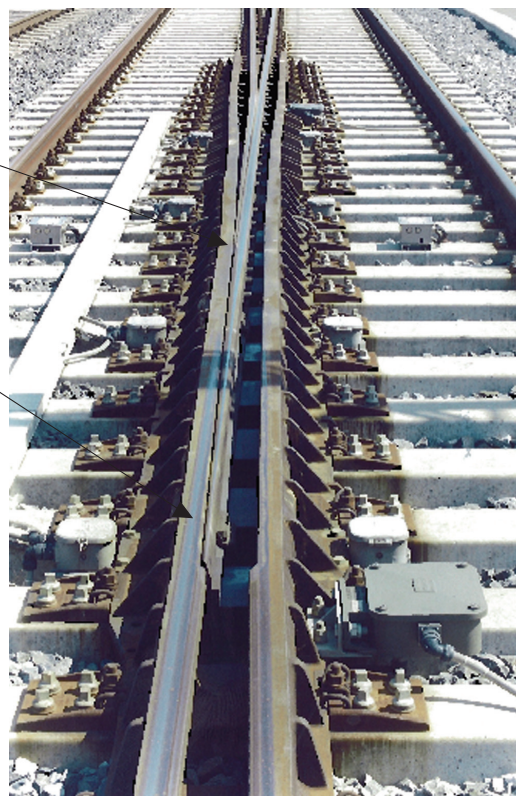
Fig. 14 – Scambio tg. 0.022 al P.M. di Alice Linea AV/AC TO- NO Zona del cuore.
