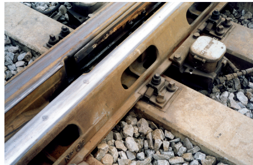
Fig. 7 – Scambio tg. 0.022 P.C. Renacci - Particolare della punta mobile e delle lavorazioni della culla in acciaio al Mn.
