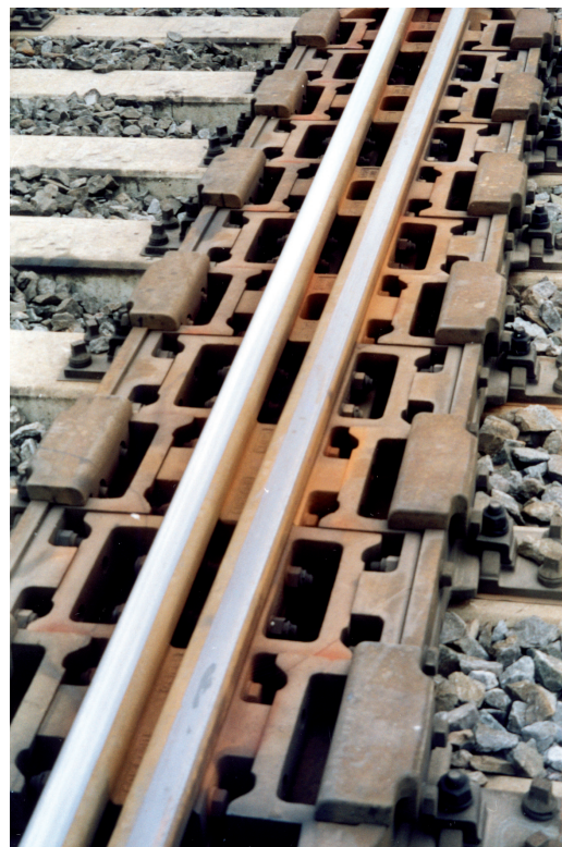
Fig. 8 – Scambio tg. 0.022 P.C. Renacci - Tallone dello scambio, blocchi di serraggio.
