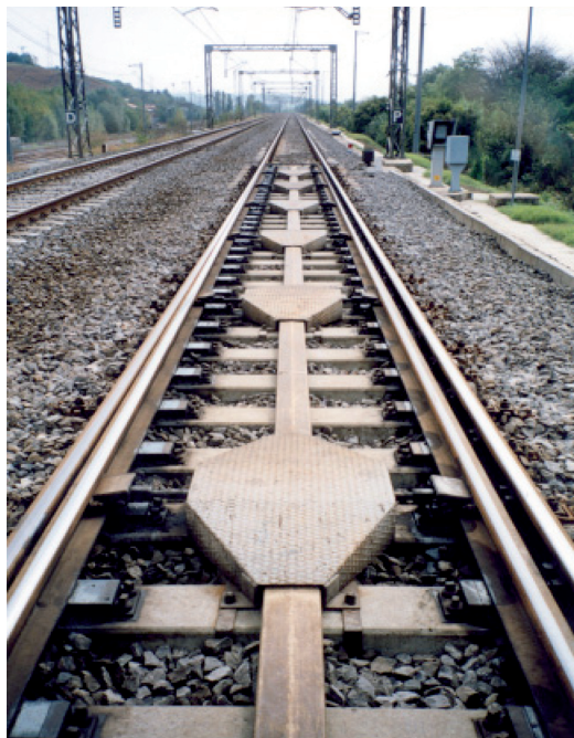
Fig. 1 – Scambio tg. 0.022 P.C. Renacci - Telaio degli aghi.
