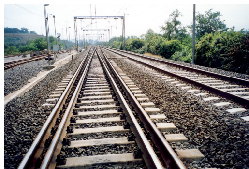
Fig. 3 – Scambio tg. 0.022 P.C. Renacci - Zona delle intermedie con posa inclinata 1/20.
