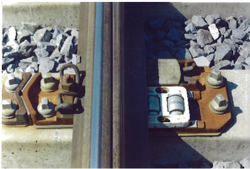
Fig. 22 – Scambio tg. 0.074 al P.M. di Alice Linea AV/AC TO-NO Cuscinetto con rulli.
