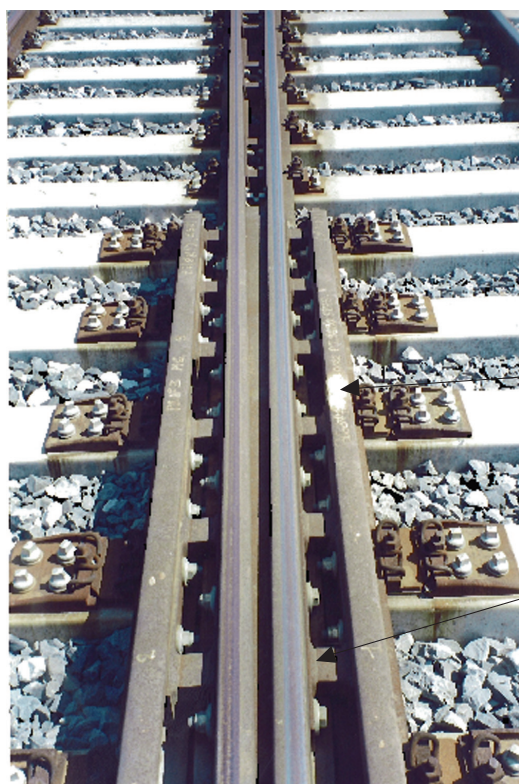
Fig. 15 – Scambio tg. 0,022 al P.M. di Alice Linea AV/AC TO-NO - Tallone dello scambio - blocchi di serraggio.
