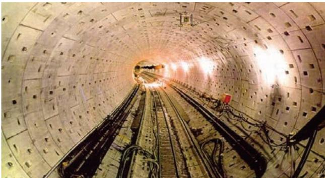
Fig. 5 - Gallerie: rivestimento previsto con lo scavo meccanizzato.
