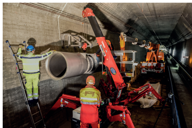
Fig. 17 - Installazione turbofan di ventilazione.
