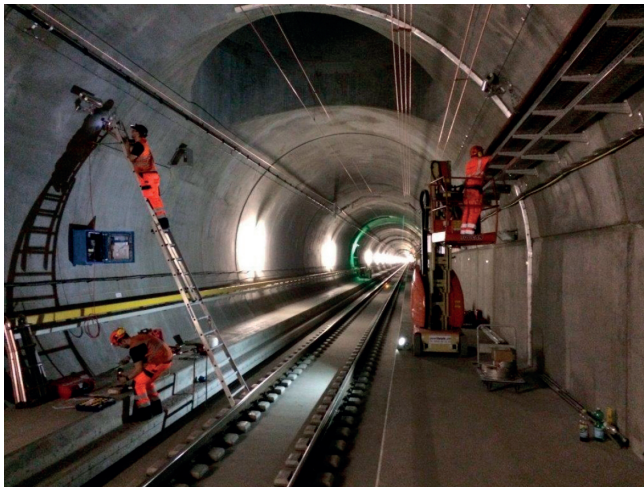
Fig. 32 - Posa impianti di telecomunicazione. Fig. 32 - Telecommunication equipment installation.
