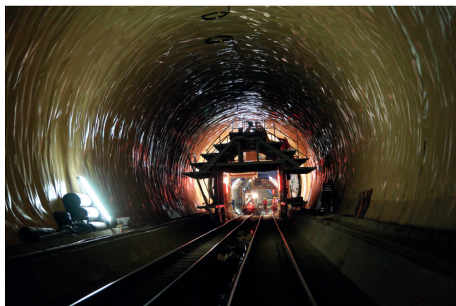
Fig. 23 - Canna est foderata con foglio di tenuta. Fig. 23 - East tube lined with sealing foil.
