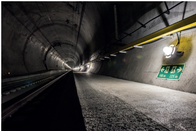
Fig. 34 - Banchine con illuminazione e segnaletica di sicurezza.
