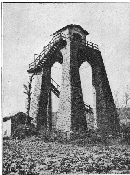
FIG. 5. — Osservatorio di Cà Trovelli per il tracciamento della grande galleria.
