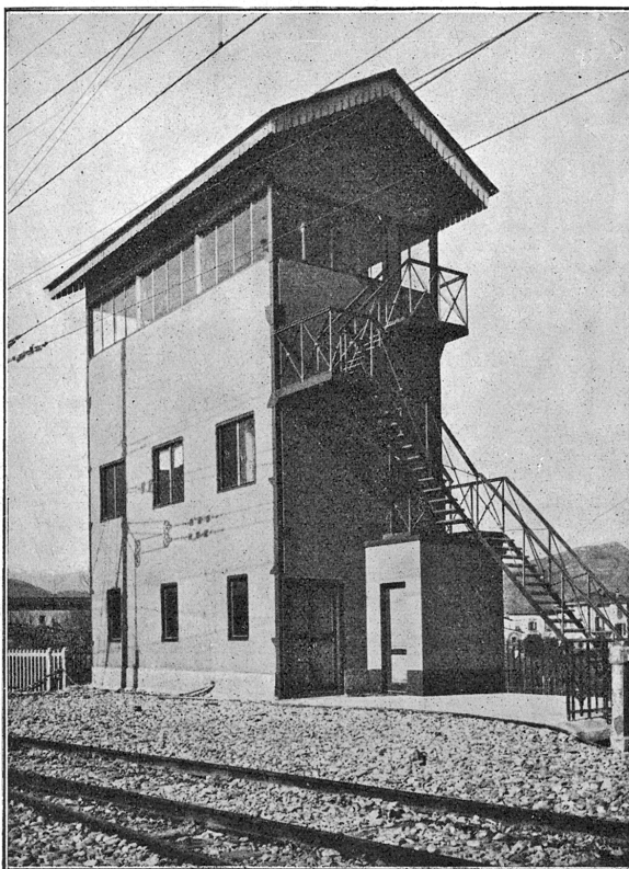
FIG. 19. — Cabina sopraelevata per apparati centrali nella stazione di Prato.
