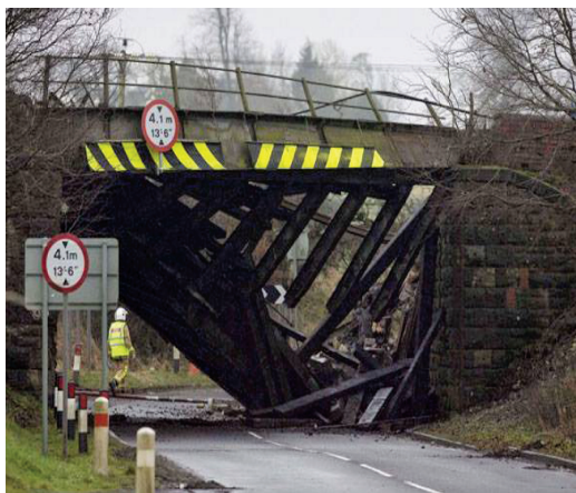
Fig. 1 - Il collasso di un piccolo ponte ferroviario in Scozia (2009), causato dal deragliamento di un treno. Collapse of a small railway bridge in Scotland (2009), caused by a train derailment.
