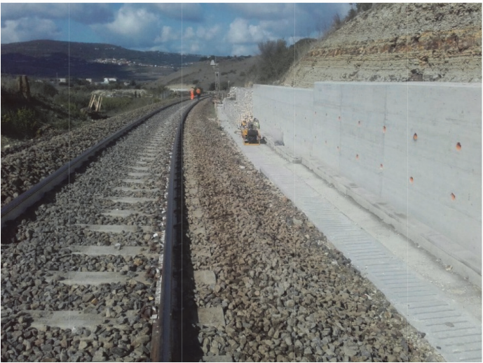
Fig. 9 - Lavori di sbancamento, posa micropali e realizzazione muro di sostegno, tratta Ploaghe-Scala di Giocca. Fig. 9 - Excavation works, installation of micropiles and retaining wall construction, on the Ploaghe-Scala di Giocca route.
