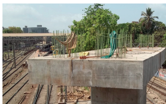
Fig. 82 - Plinto già realizzato.
