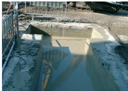
Fig. 18 - Lo scavo dello sperone. Spur excavation.
